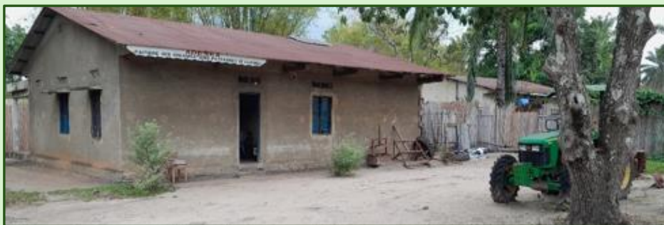
Photo : terrain sur lequel ADESKA veut construire le hangar dans lequel les machines et équipements du projet seront installés
