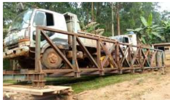
Fabrication du pont VIHULI à l'atelier du GAB.
