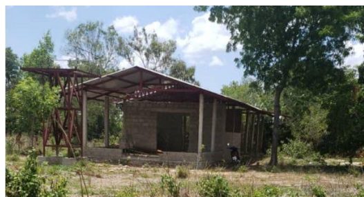
Le gros œuvre de la cassaverie de Pignon est terminé.
