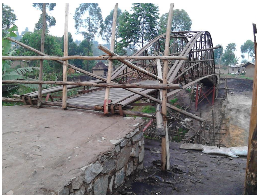
Installation d'une passerelle à Butembo en RDC pour la traversée des profondes ravines dues à l'érosion.
